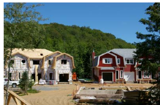
Bâtiments 6, 5 (gauche à droite) et les fondations du bâtiment 16.
